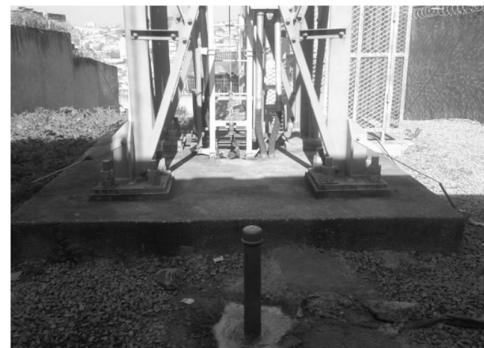
Figura 2. Vista frontal da base da torre.
